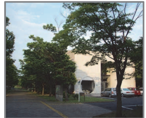
13号館（体育研究棟）
