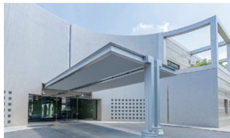
5 管理棟(受付付近)
